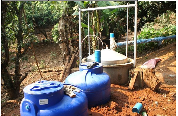
ガス収集装置（向こう側からガス収集槽⇒第2処理槽⇒第3処理槽⇒畑）
