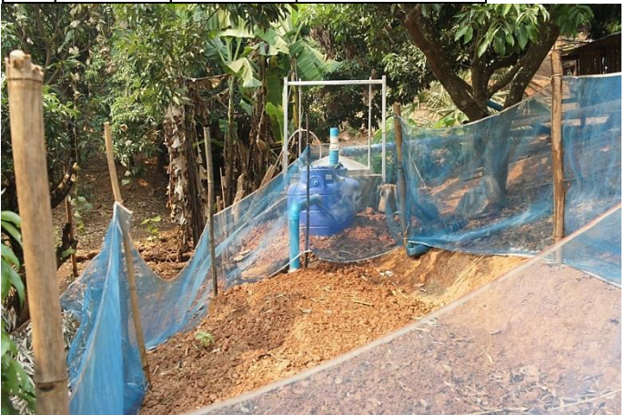
ガス収集装置（向こう側からガス収集槽⇒第2処理槽⇒第3処理槽⇒畑）
