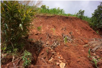
崩落被害の一部
