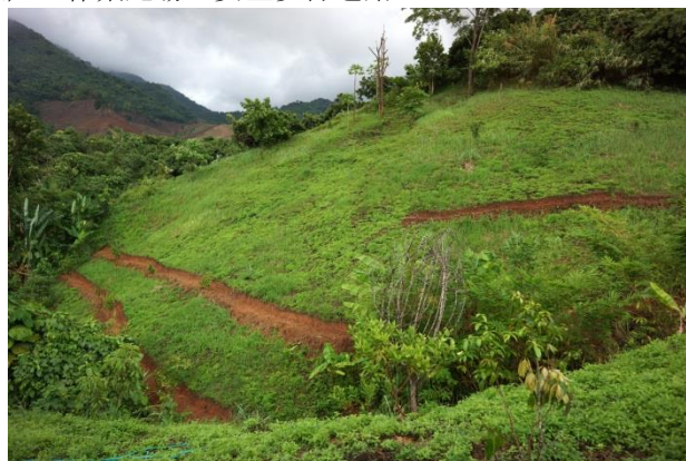
崩落防止試験 作業中
