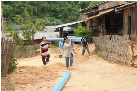
村内配管施工
