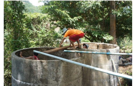
旧貯留槽補修作業
