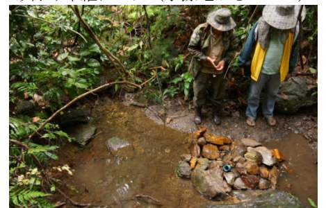
取水状況 (清掃・ごみ対策)
