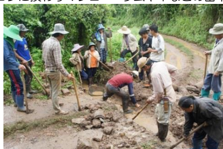
ホイブム村水路・道路補修作業
