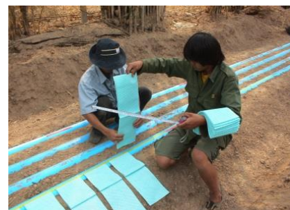
クンガムラン村設置の「エコトイレ」 最終処理装置の製作状況
