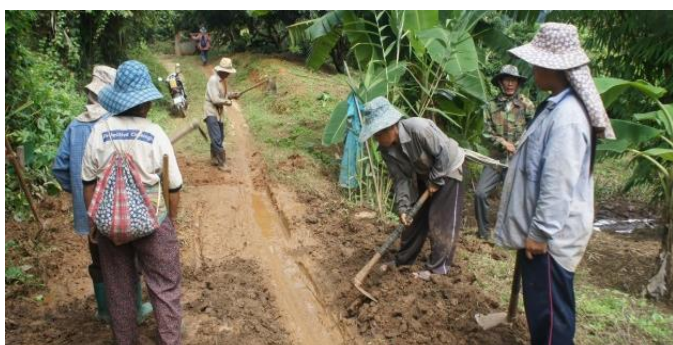
村への進入路の補修作業
