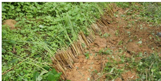
ヤーフェーの植栽完了
