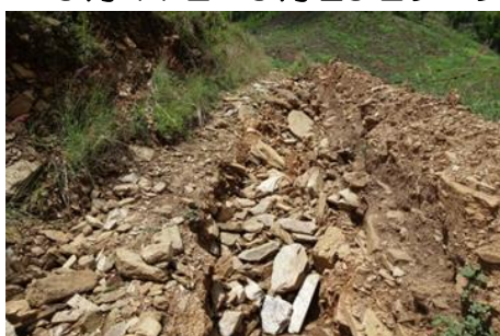
木を切ったため鉄砲水による通路の浸食
