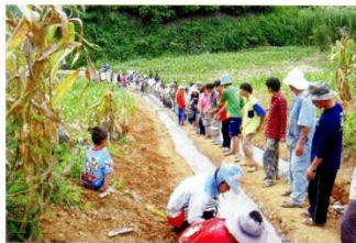
村民総出で行われた栽培地に続く 作業道の補修
