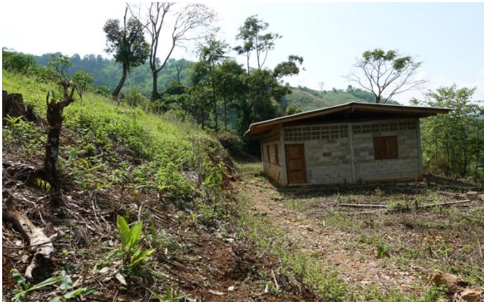
タマサート大学生ボランティアでできた未完成の保育所
