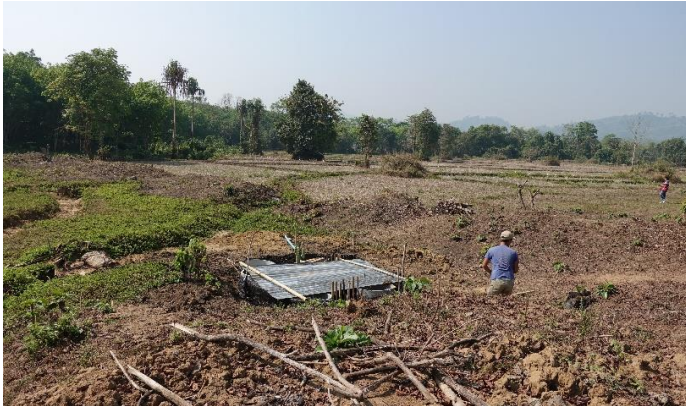
新建設地(1.3ha)・完成の井戸(みんなで掘り上げました)
