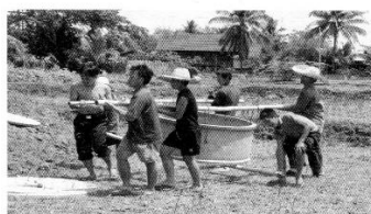
トイレ改修作業
