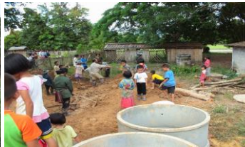
トイレ設置作業子供たちも「声援で」手伝います
