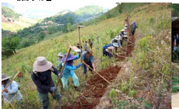
水源地から5キロメートルの水道管布設作業
