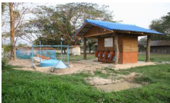
村の共同トイレと処理装置
