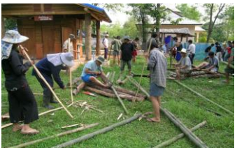
村の共同トイレ設置作業
