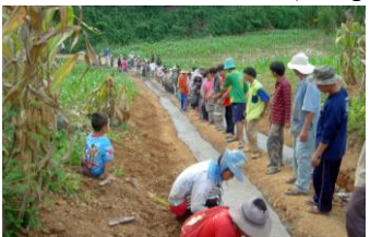
洪水で壊れた道路補修作業
