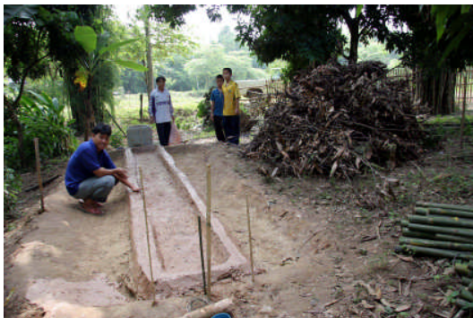
装置の器基礎完成
