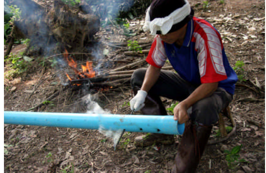
集水管の穴あけ
