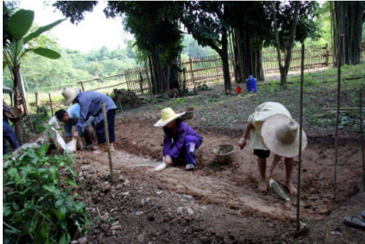
粘土による地盤加工
