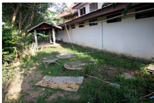
改修予定の処理槽（男子寮）
