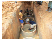
処理槽基礎部
