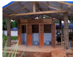
トイレ部完成
