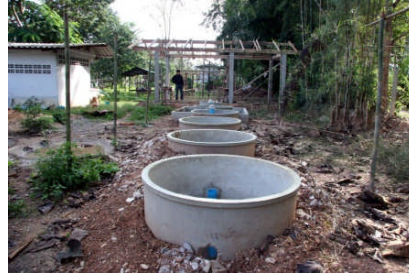
処理槽設置完了
