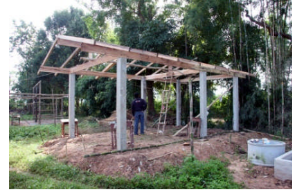
トイレ建屋施工状況
