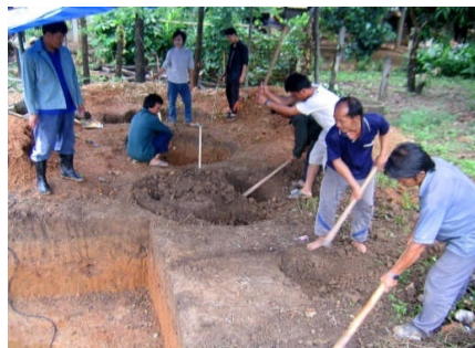
処理槽の掘削・設置
