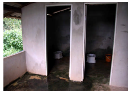
トイレ内部（大人用のため危険）
