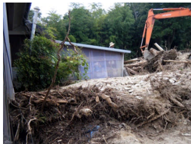
重機による取り除きが始まった
