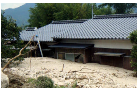
床上以上に土砂被害を被った民家
