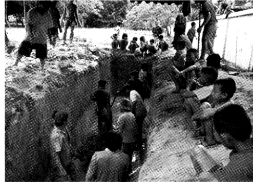
写真-6 粘土質と格闘しながらの穴掘り
