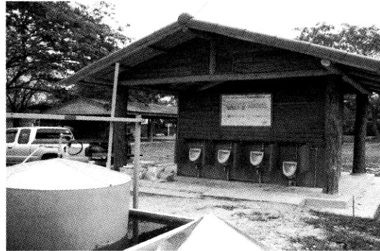
写真-2 自然循環式エコトイレシステム (パヤオ方式)の外観
