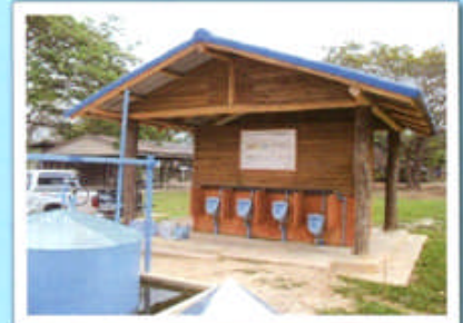
トイレとガス収集タンク
