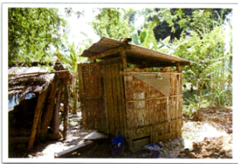
簡素な古いトイレ
