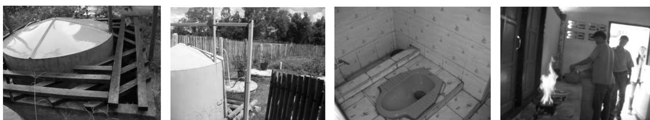
図2 プラチャーパクディー保育園の改良トイレとその周辺設備 A メタン発酵槽周辺、B メタンガスが蓄積されたメタン発酵槽（1槽）と下流の第2～第6槽、C タイ式水洗トイレ D トイレ発酵槽のメタンガスを用いたコンロが整備された調理室
