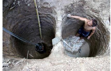
女子寮の穴掘り 既設の改修のため2,6m 掘った。(新設だと1.8m)最悪の水が湧いた！
