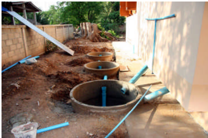
処理槽設置状況
