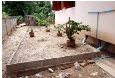
完成状況（未植栽）
