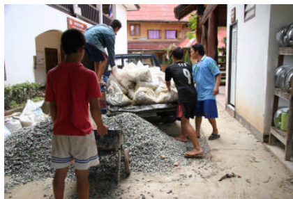
資材運搬作業中
