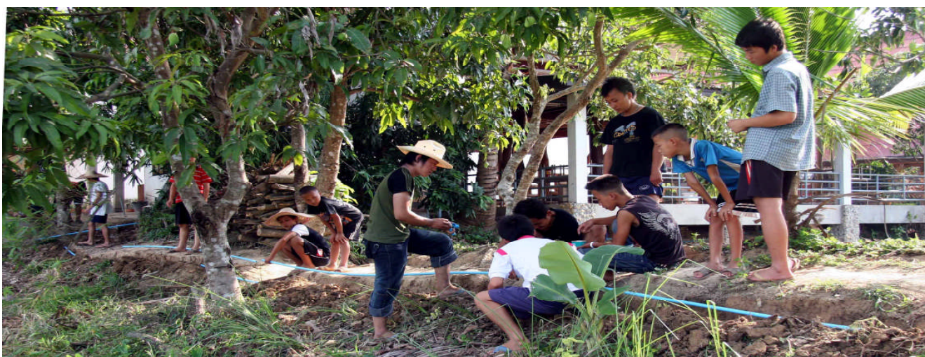
豚舎から台所まで30mのガス管配管工事
