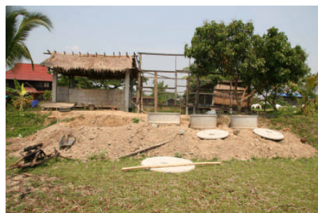
工事中（向こう側は、養殖池）
