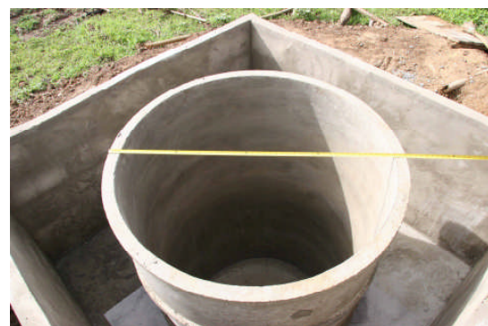
完成（タンク内径1.2m・水槽2m×2m）
