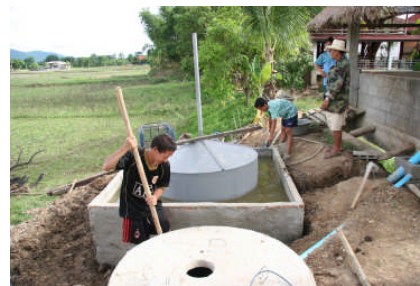
ガス天支持基礎工事（まもなく完成）
