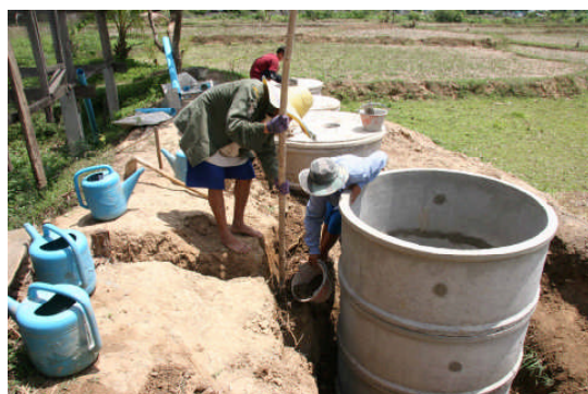
ガス収集槽設置工事
