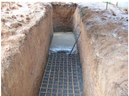
基礎コンクリート（竹筋敷設）
