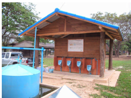
トイレとガス収集タンク
