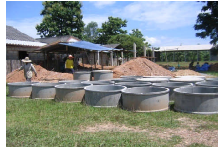
掘削処理槽搬入
