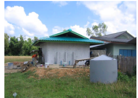
外部男子トイレ部分
