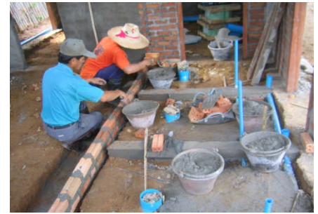
外部トイレ部分施行
