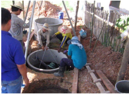
処理槽据えつけ
