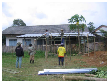
仮設屋根工事
