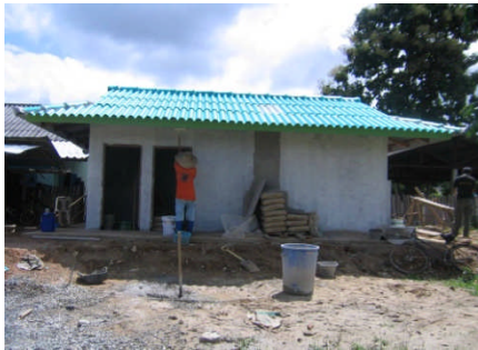
外部トイレ部分
