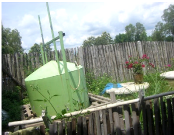
トイレのガスタンク
